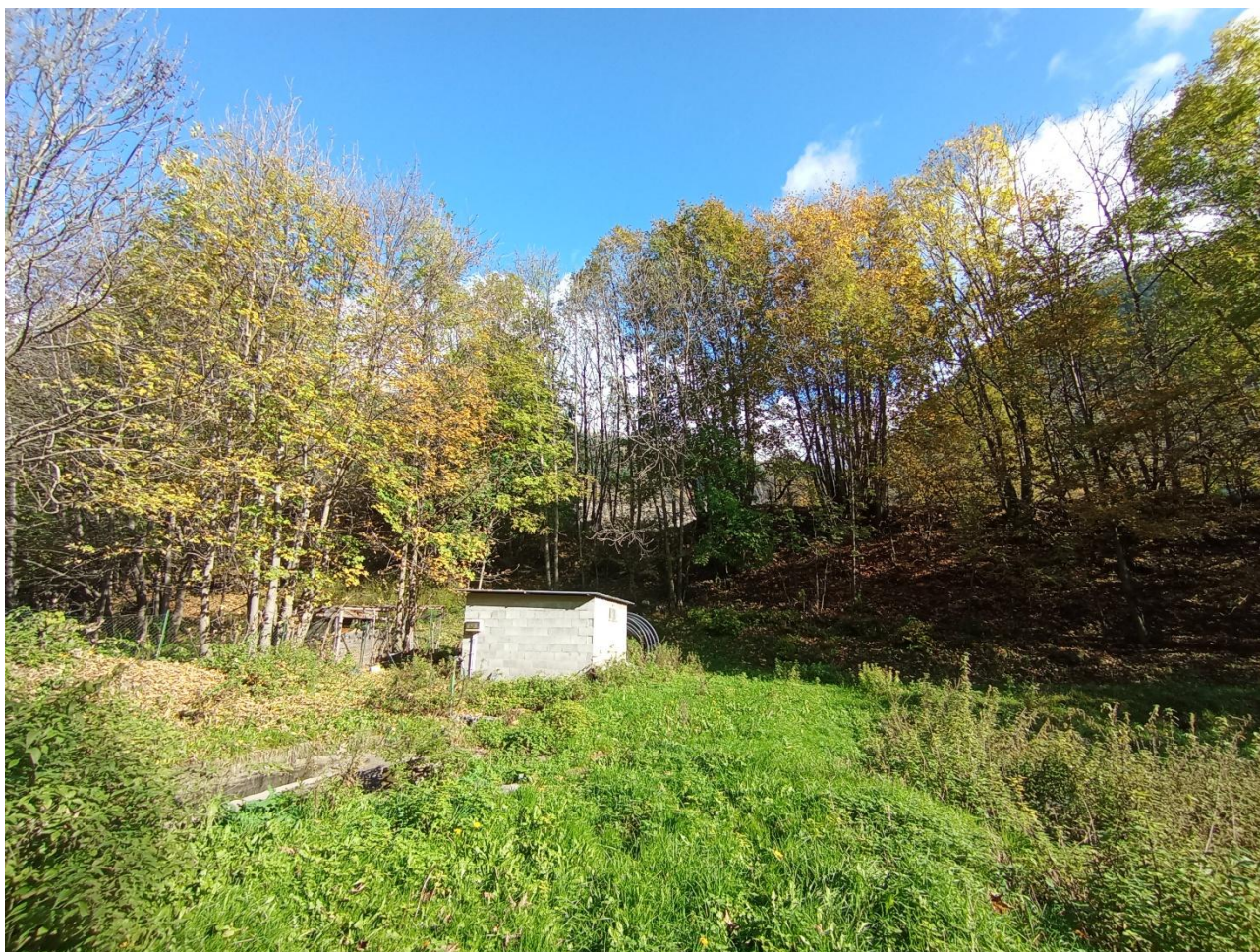
Foto 3 _ L'immagine ritrae l'area SPI6 dove insiste il sistema del depuratore e la scarpata arborata a monte. In secondo piano, sulla sommità della scarpata, tra i fusti degli alberi si intravede il muro che delimita l'ara ZN3.
