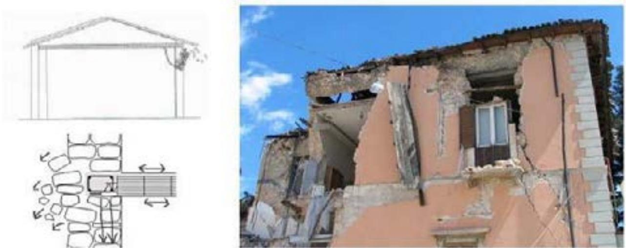
**Figura 14 – Abruzzo 2009 – Danneggiamento di muratura in presenza di cordoli in c.a. (fonte: Governare il rischio 2012)**
